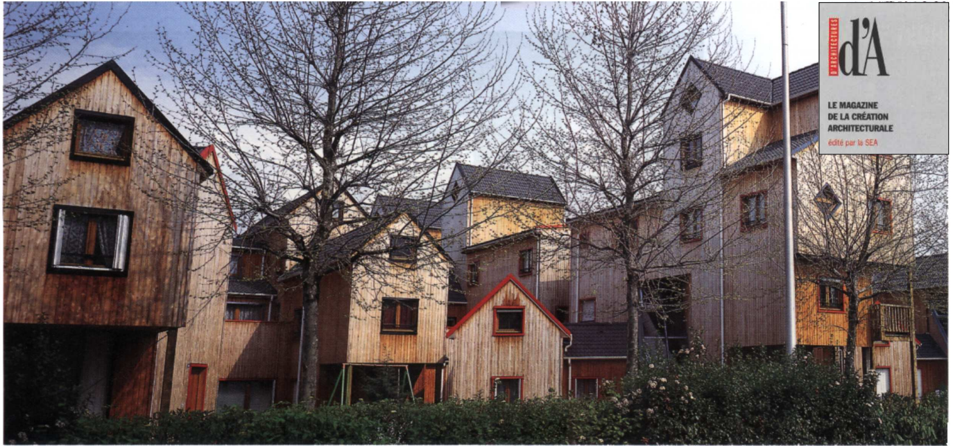
A Saint-Martin D'Hères, la cité de la Cerisaie avec ses maisons de bois superposées.
